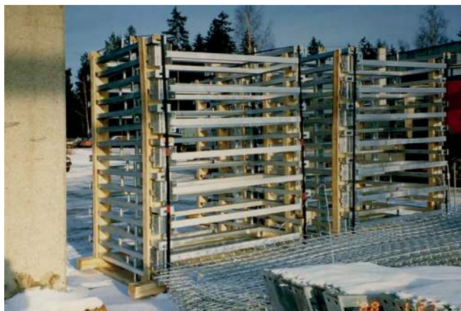
Figur 2. Profiljern og konstruktioner lagres med hældning og vendes således, at vandsamlinger undgås. Der placeres mellemlæg, så der ikke opstår spalter og således at alle flader ventileres.
